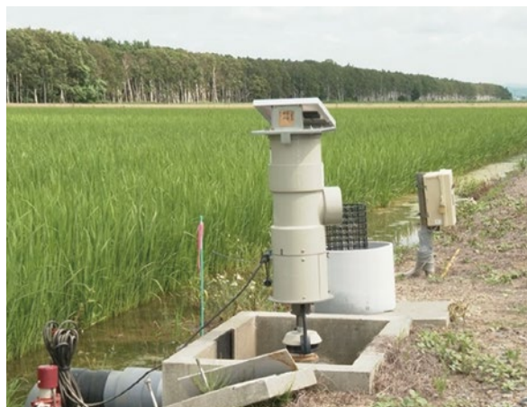
スマホやPCで状況がわかり、給排水のコントロールができるシステムの例
